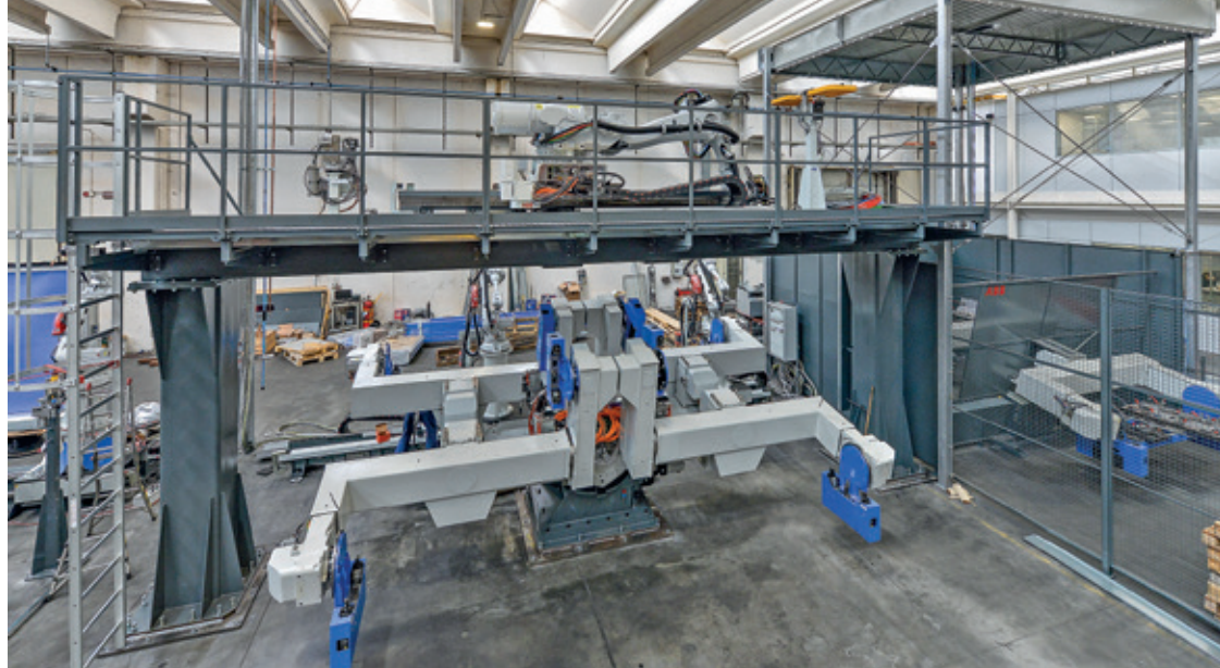
Installazione in corso del nuovo impianto Fms
