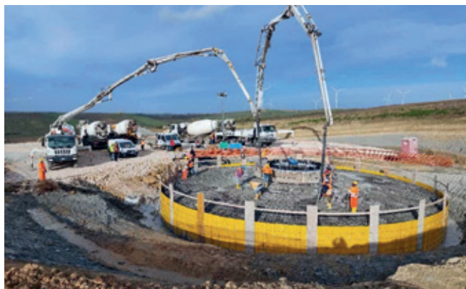
Lavorazione al parco eolico
