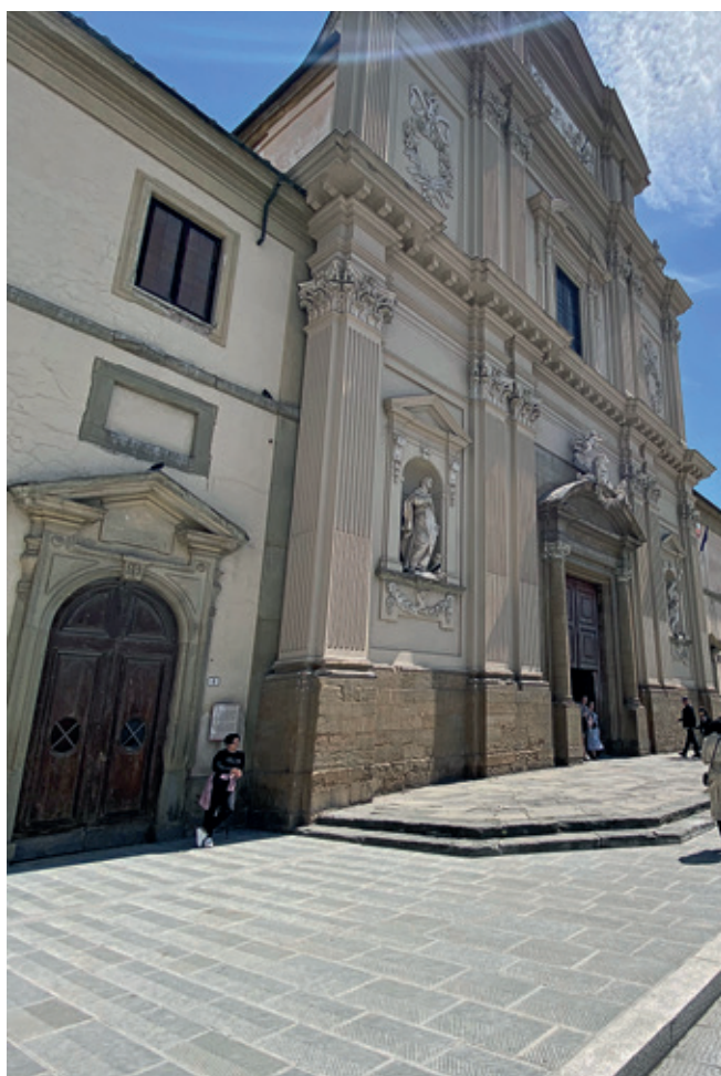
Piazza San Marco (Firenze) a installazione completata
