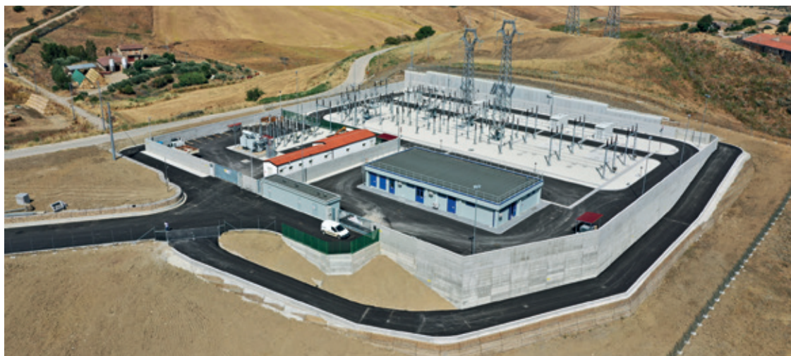
Realizzazione sottostazione elettrica
