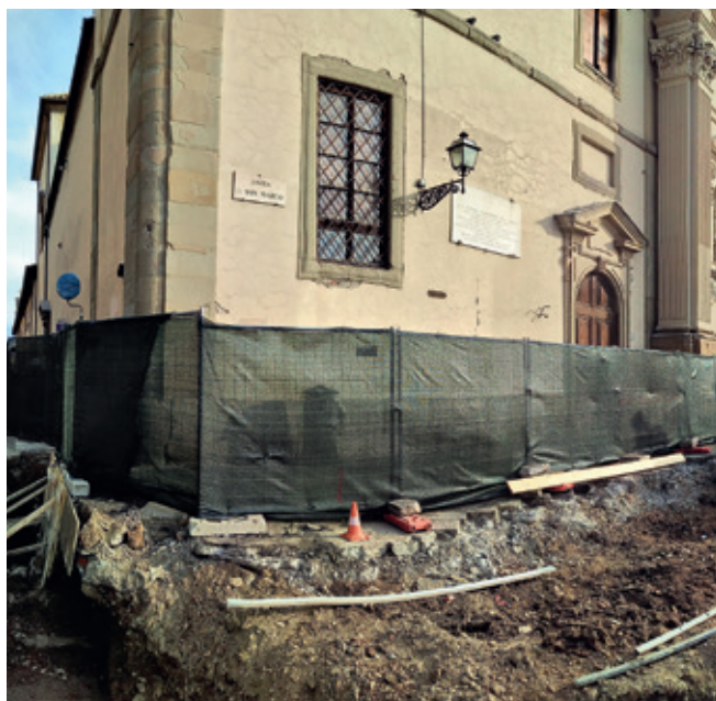
Lavori ante operam: scavo per inserimento pannelli antivibrazioni NoViDamp a protezione dalle vibrazioni prodotte dal transito di tram, bus e mezzi pesanti della Basilica di San Marco in Firenze
